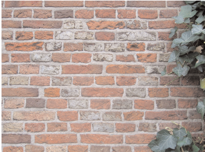
Afb. 1. Metselteken in de westgevel van Vijfde Binnenvestgracht 7 uit 1588 (d) (foto E. Orsel).
