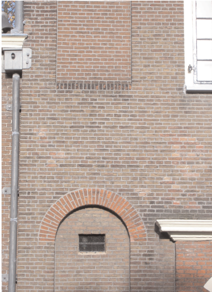
Afb. 19 (rechts). Kloksteeg 21 te Leiden, het Pesijnshof uit 1683, metselwerk met een kopklezoor en een drieklezoor als hoekoplossing (foto E. Orsel).
