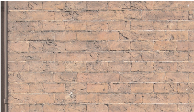
Afb. 15. Nieuwe Rijn 12 te Leiden uit 1790, op de strekken en koppen van dit zeer strakke metselwerk in kruisverband zijn verticale kraslijnen aanwezig, om de verticale voegen uit te kunnen lijnen. De hoekoplossing is uitgevoerd met een kopklezoor (foto E. Orsel).
