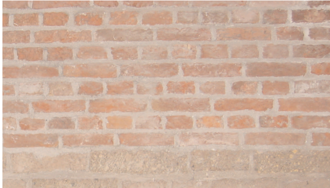
Afb. 11. Het Gravensteen te Leiden, kruisverband in de ophoging uit 1463 (
