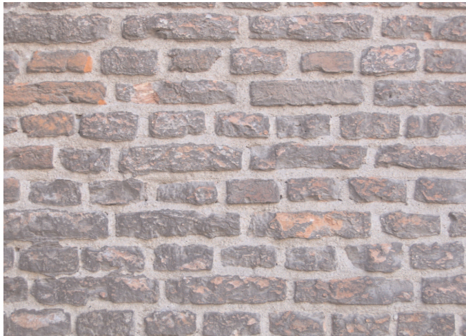
Afb. 12. De Pieterskerk te Leiden, staand verband op de noord-westhoek uit 1453-1473 (foto E. Orsel).
