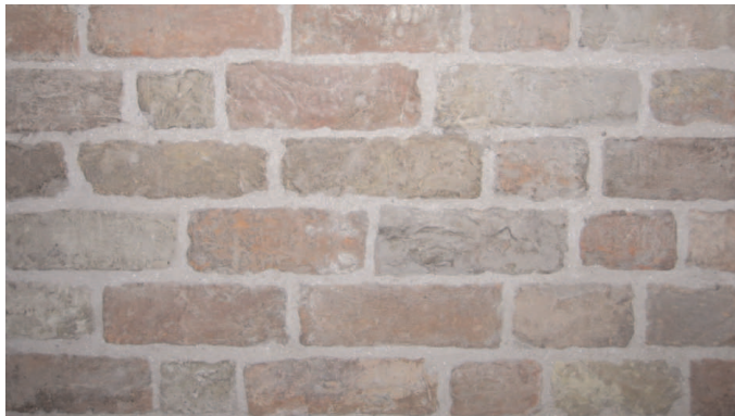
Afb. 3. Het Gravensteen te Leiden, Noor(d)s verband in de westgevel van omstreeks 1200 (foto E. Orsel).
