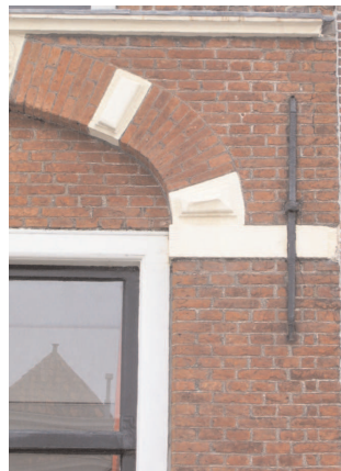
Afb. 16 (links). Vijfde Binnenvestgracht 7 te Leiden uit 1588, met een drieklezoor als hoekoplossing (foto E. Orsel).
