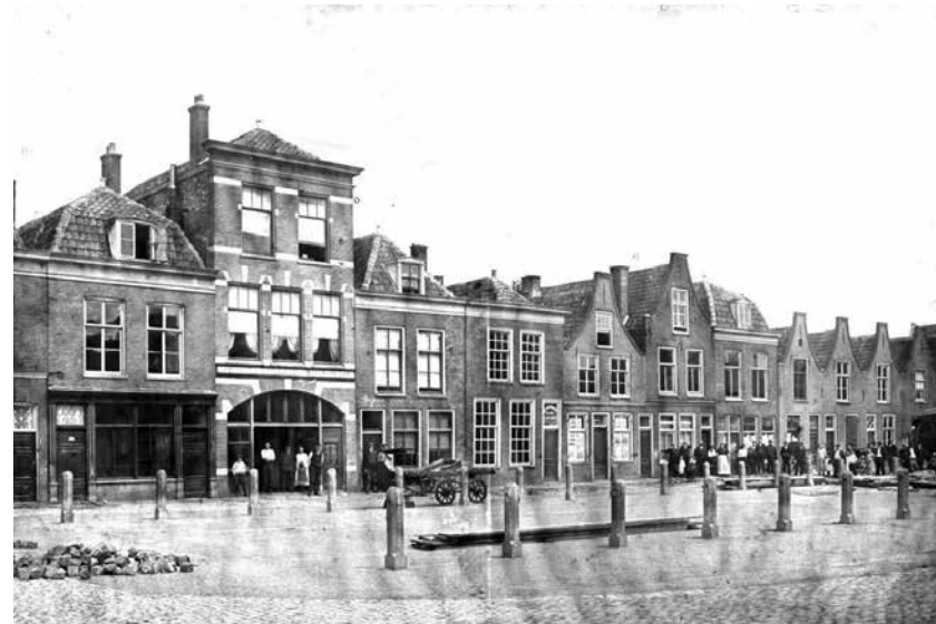
In 1906 gesloopt bouwblok aan de Lammermarkt. Het archeologisch onderzoek bracht de funderingen aan het licht. Op de voorgrond de toen al gedempte Korte Langegracht, ca. 1900. (GN004779)
