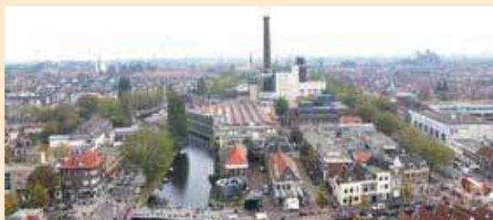
Zonnepanelen op gebouw De Nieuwe Energie. Foto: Energiek Leiden
