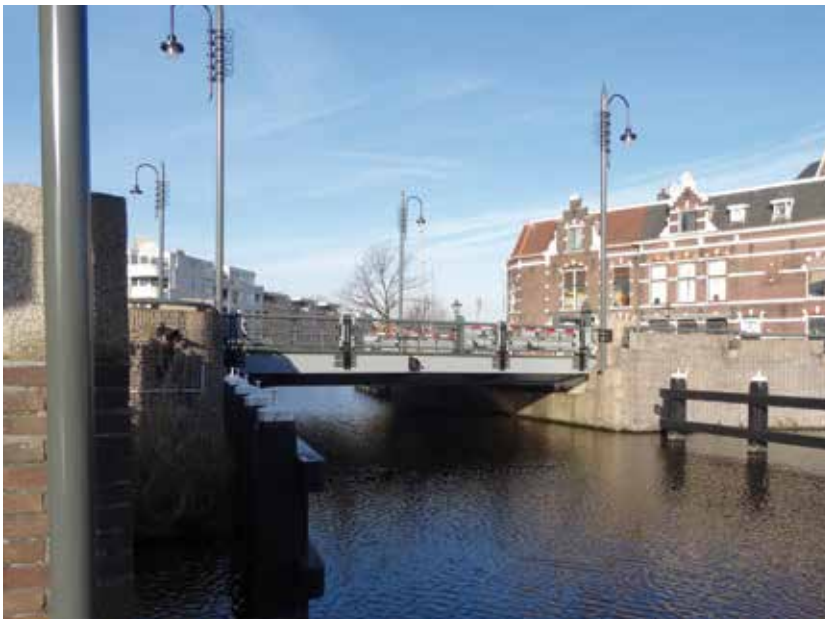
Grote Havenbrug na herstel historisch kleurbeeld.
