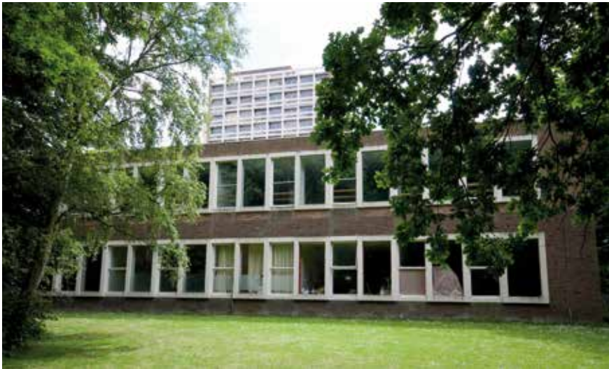
De langgerekte raampartijen van de laagbouw zijn verbijzonderd door brede betonnen kozijnen, die per venster om en om terugwijken en uitsteken. Dit is het lokale deel, opgehoogd in 1986, aan de westzijde van Nieuweroord.
