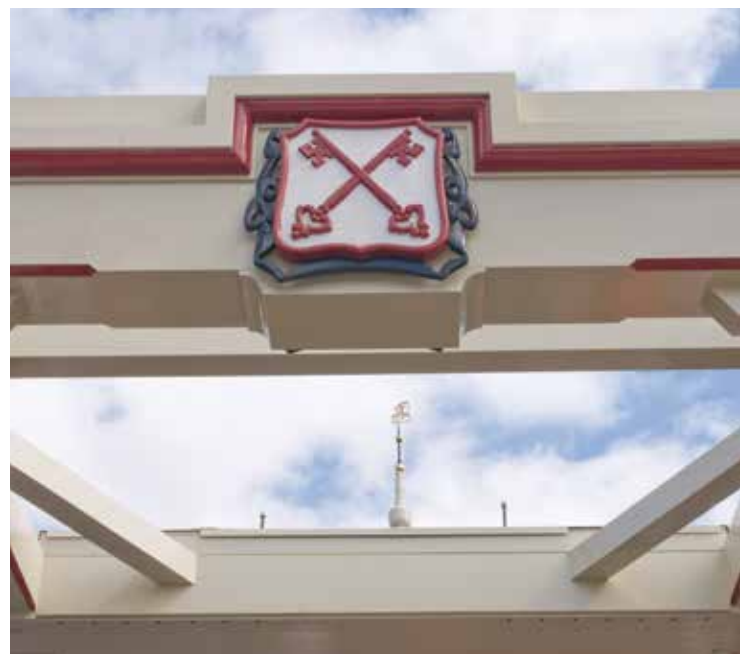
De Morspoortbrug (detail).
