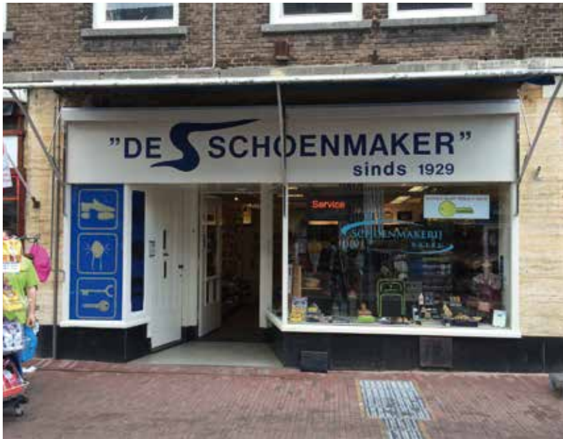
De winkelpui van Korevaarstraat 6 voor herstel. Foto: Ton Koreman
