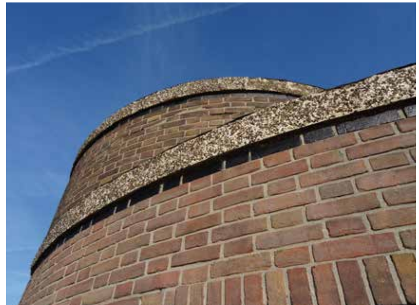
Grote Havenbrug, detail van transformatorgebouw.
