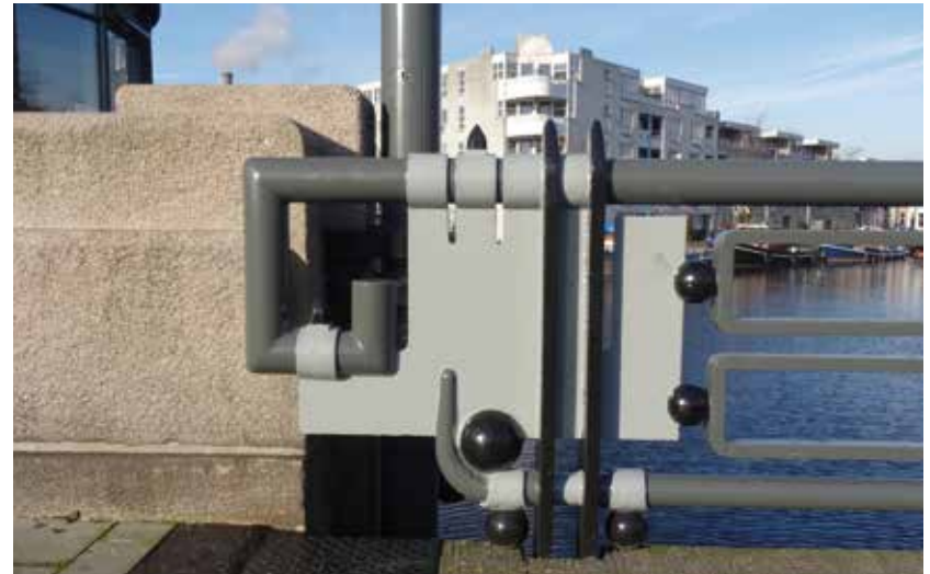
Detail leuning Grote Havenbrug na herstel historisch kleurbeeld.
